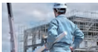
建設・工事現場
